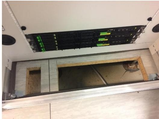
**Abbildung 93: Serverrack mit Unterbodenbelüftung in der KDO**
